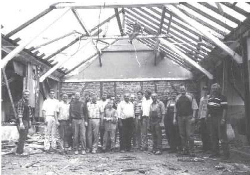
Abriss der alten Turnhalle
