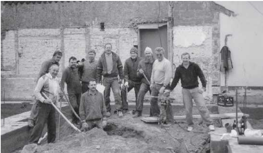
Bauhelfer am Fundament des flic-flac, 1993
