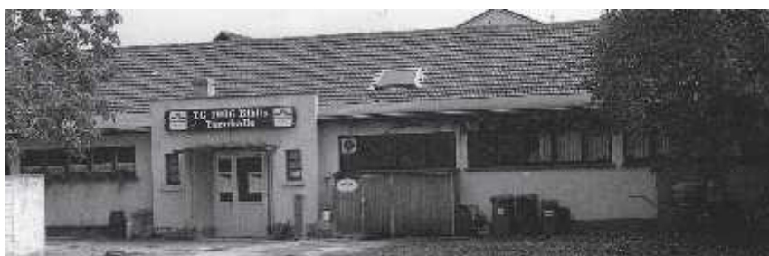
Die Jahnturnhalle bis zum Abriss im September 1994
