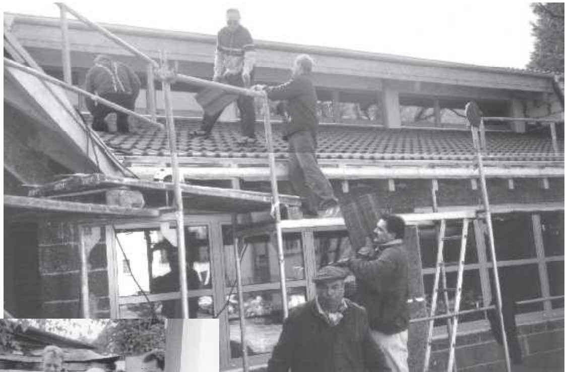
Bau der neuen Jahnturnhalle, 1995
